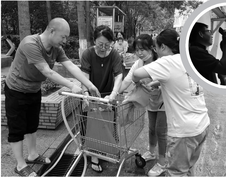
▲物业人员紧急抢修漏水管线
